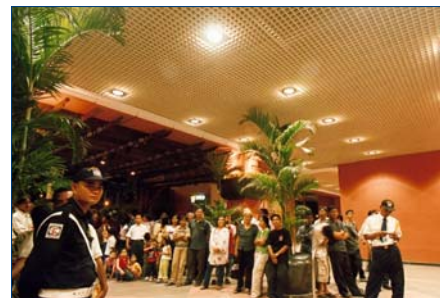
Réalisation phare de SMS : 17 000 m 2 de plafond métallique à l'aéroport de Phnom Penh (Cambodge)
